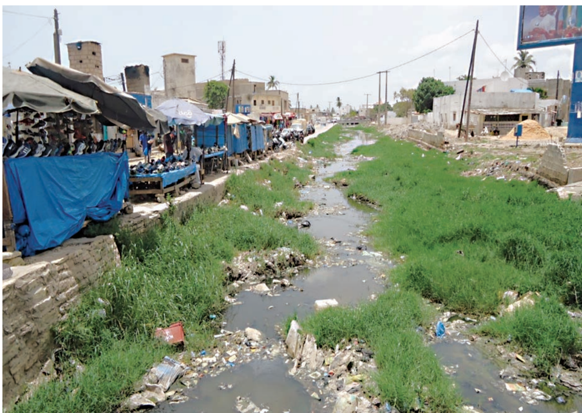
Photo 3 : Canal rempli d'ordures où se développent les végétaux aquatiques
