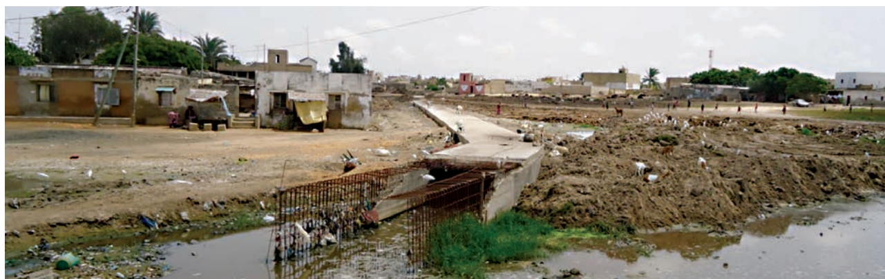
Photo 1: Construction du canal de Darou Rahmane
