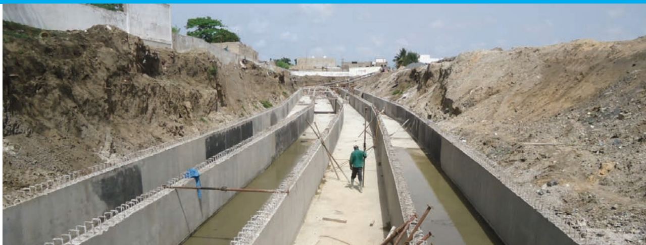
Photo 4 : Construction du nouveau canal central
